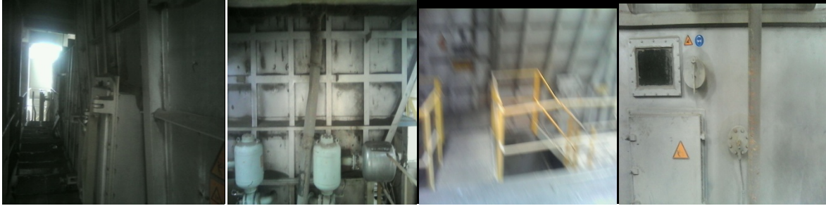
Fotos 18, 19, 20, 21 y 22. Punto de muestreo N°12: Paredes del enfriador
