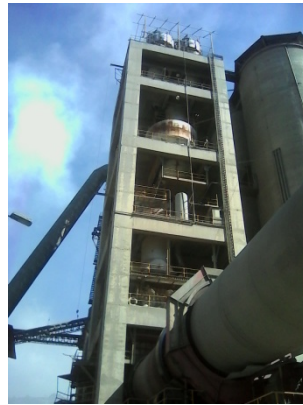
Foto N°1: Pre-calentador de la Planta Guapán- UCEM
