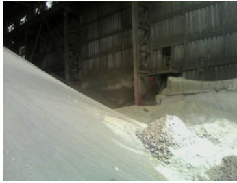
Foto 27. Punto de muestreo N°16: Zona de salida del clinker al hall de almacenamiento
