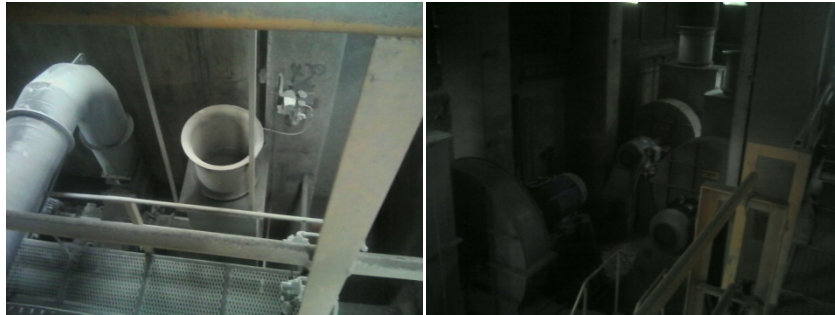
Fotos 15 y 16. Punto de muestreo N°10: Zona de ingreso de aire de enfriamiento en los ventiladores del enfriador de clinker (F17, F18, F19, F20 y F21)
