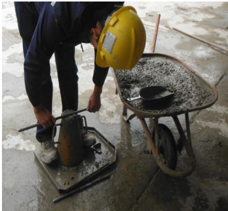
Figura 15. Imagen del enrazamiento de la superficie del hormigón fresco.
