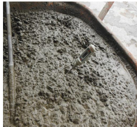
Figura 18. Imagen del control de temperatura del hormigón fresco.
