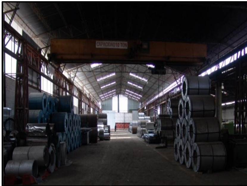
Figura 1.1: Bodega de materia prima.
