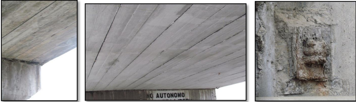
Ilustración 7.1 Tablero del Puente Iberia, El Oro: (izquierda) Vista de los apoyos de la viga; (centro) Unión de las Vigas; (derecha) Detalle del pos tensado transversal
