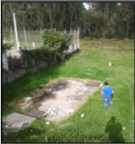
PTAR Cruz Verde. Aunque esta junto a la vía principal, existe un desnivel entre la vía y la planta de 3 metros aproximadamente.
