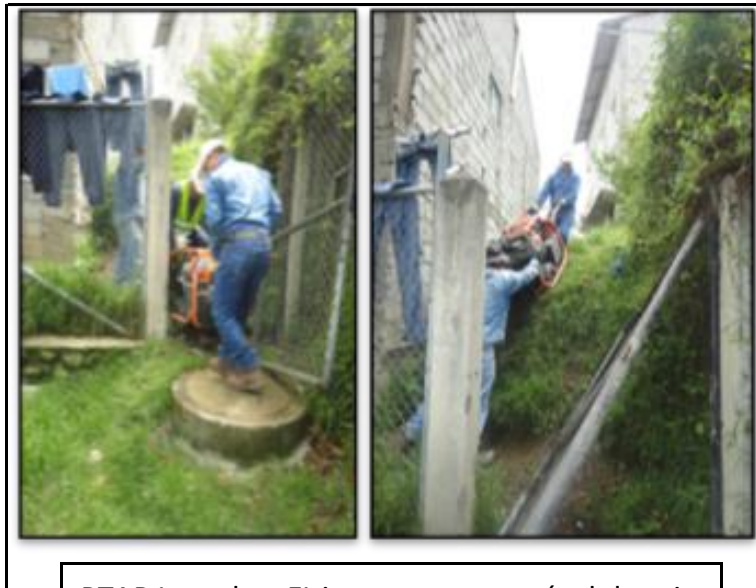
PTAR Laureles. EL ingreso es a través del patio de una casa junto a la planta, donde no existe un camino adecuado para ingresar con maquinaria.
