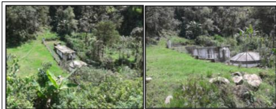
PTAR San Antonio. Existe solo ingreso peatonal. La planta está a unos 60 metros hasta donde puede llegar el vehículo
