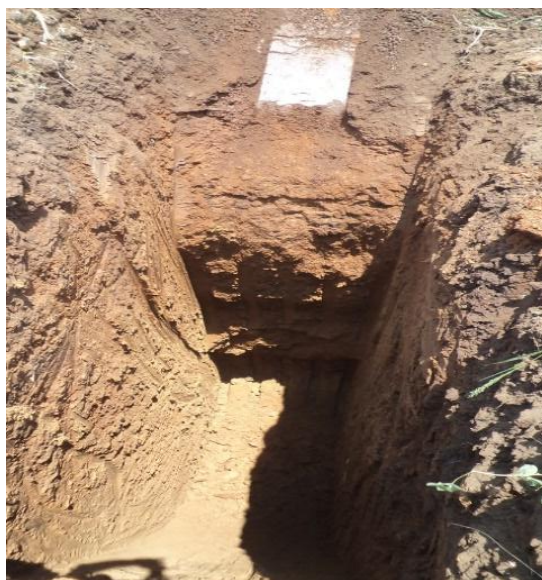
Figura 2.2. Trinchera 3 profundidad de 2.00-6.00 m
