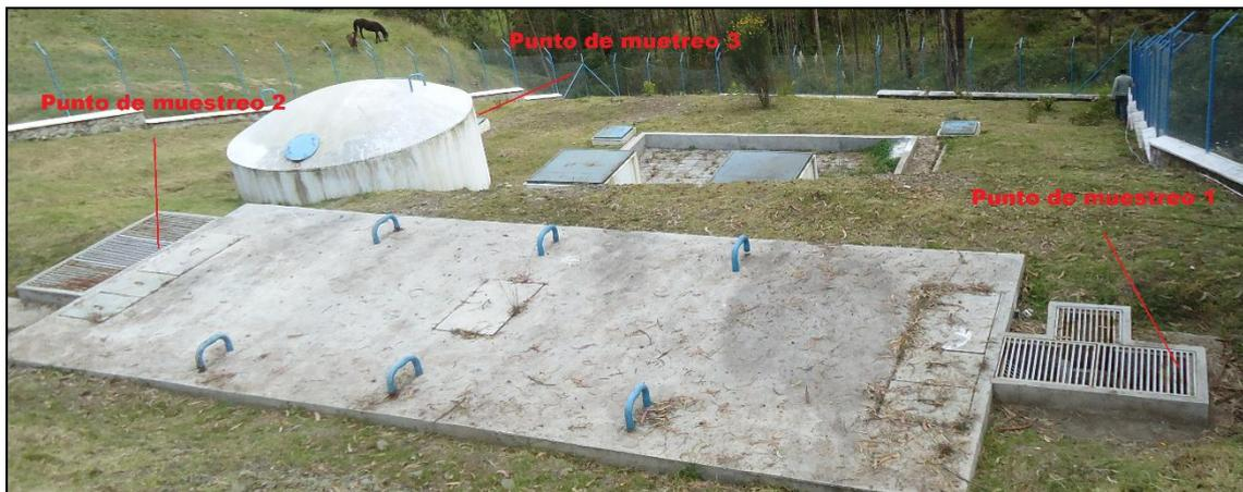
Figura 4-2 Puntos de muestreo de la PTAR San Pedro
