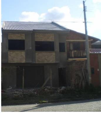
Foto 29. Vivienda de dos plantas, para construir la estructura de hormigón se empleó encofrados de madera elaborados artesanalmente en obra, y para la construcción de paredes y muros se utiliza el ladrillo. Parroquia Sucre
