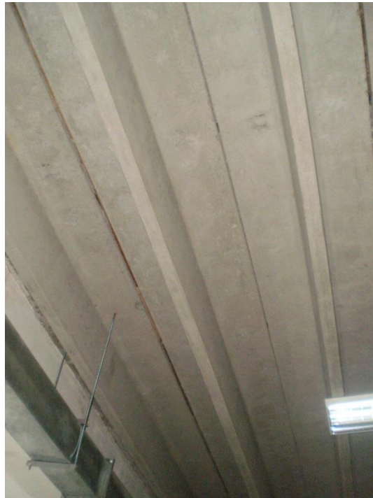
Foto 102. Losa tipo T de 17.5 m de luz, Parqueadero del "Parque de la Madre".
