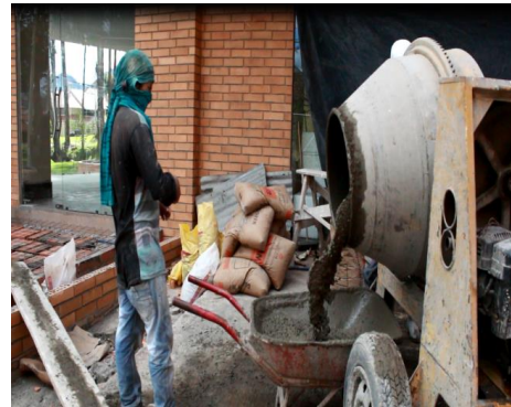
Foto 7. Arena utilizada para concreto, y elaboración de concreto In Situ en construcción de vivienda. Sector el Valle.
