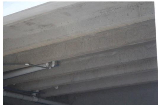
Foto 89. Losas de sección doble T prefabricadas, luz 6 m, para losa de entepiso. Arq. Carlos Contreras. Calle Benito Juárez
