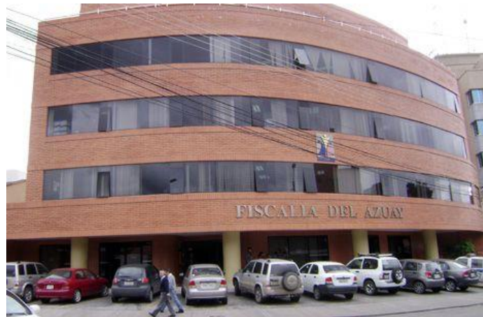
Foto 3. Edificio de la Fiscalía del Azuay. Construido por el Arq. Claudio Ullauri, se empleó un método constructivo tradicional, la estructura es de hormigón armado y el hormigón es elaborado en obra. Utiliza también encofrados metálicos y de madera. Fuente: www.cuencanos.com
