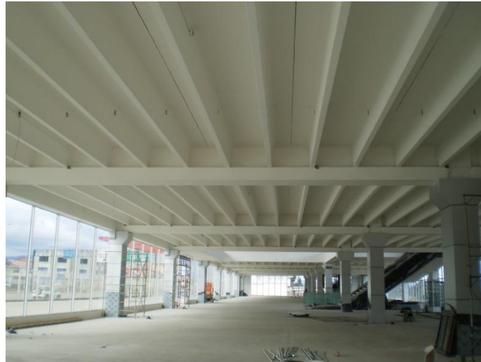
Foto 98. Estructura de la primera planta, “Ferretería Continental”
