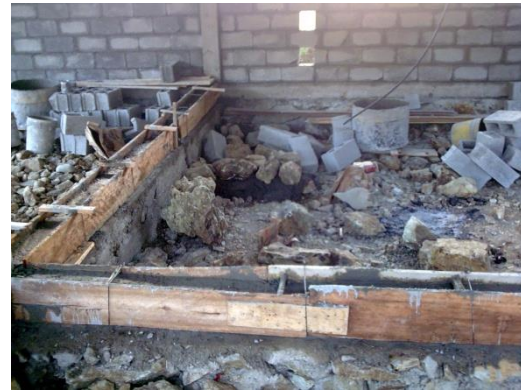
Foto 18. Vigas de cimentación, con encofrados y hormigón elaborados en obra. Resultado de la práctica de la albañilería. Vivienda de dos plantas. Construcción tradicional. Sector San Joaquín.
