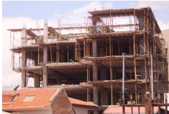
Foto 54. Edificación de seis plantas con puntales y cerchas metálicas para losa. Construcción con Sistemas de Encofrados y aplicación de hormigón en plantas altas mediante bombeo con ayuda de mixer de concreto. Ing. Fabián Oramas Av. Manuel J. Calle.
