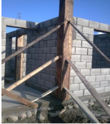
Foto 17. Encofrado de columnas, elaboradas artesanalmente y puntales de madera. Edificación de una planta, área de construcción 120 m2. Arq. Bolívar Abarca. Parroquia Ricaurte.
