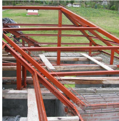
Foto 11. Cubierta con estructura metálica. Vivienda unifamiliar. Sector Challuabamba
