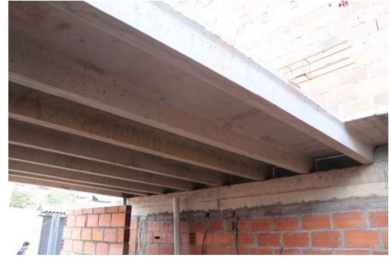
Foto 90. Losas doble T prefabricadas, se adaptan a diseños arquitectónicos y estructurales. Calle Benito Juárez
