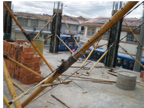
Foto 37. Apuntalamiento en los encofrados metálicos de las columnas. Edificación Calle Manuel Vega.
