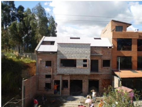
Foto 27. Vivienda de dos plantas, construcción con estructura de hormigón armado elaborado en obra, los encofrados utilizados son de madera y mampostería de ladrillo, tiempo de ejecución de la obra diez meses. Sector Av. 10 de agosto.
