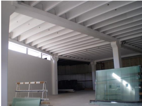
Foto 96. Subsuelo "Ferretería Continental", construido con elementos prefabricados de hormigón pretensado para losa de sección doble T.
