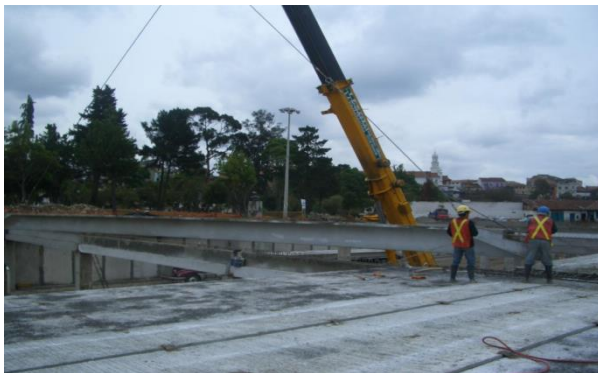
Foto 70. Proceso de montaje, de losas de sección T, utilizadas en la construcción del Parqueadero subterráneo en el proyecto: “Rehabilitación del Parque de la Madre”, que se realizó en el año 2012.
