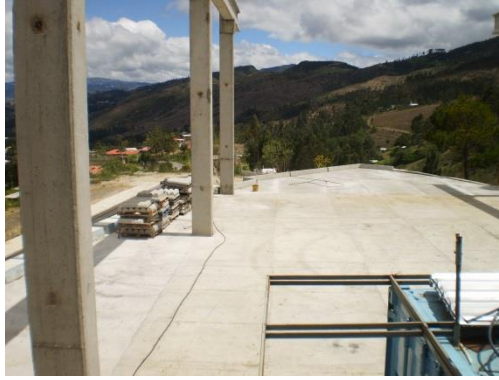
Foto 65. Ampliación de las instalaciones, destinadas para el almacenaje de los elementos estructurales prefabricados, fábrica Carrasco RFV Construcciones.
