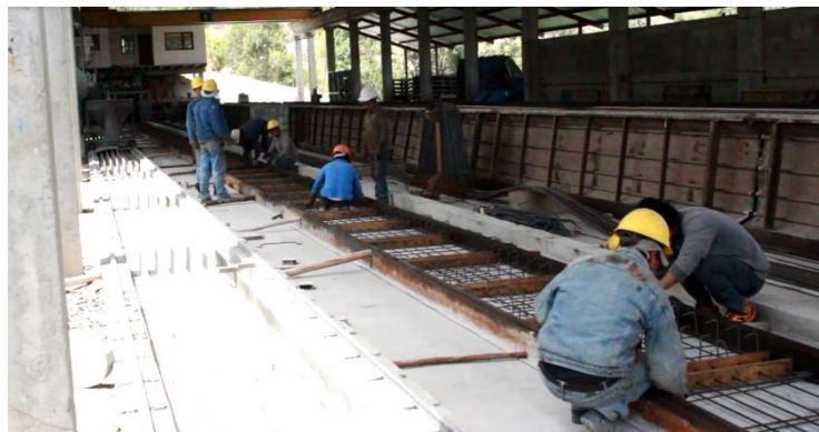
Foto 64. Operarios trabajando en el armado de estribos en losa para puente, fábrica Carrasco RFV Construcciones.
