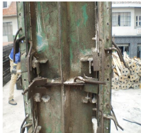
Foto 45. Detalle de encofrado metálico de columnas.
