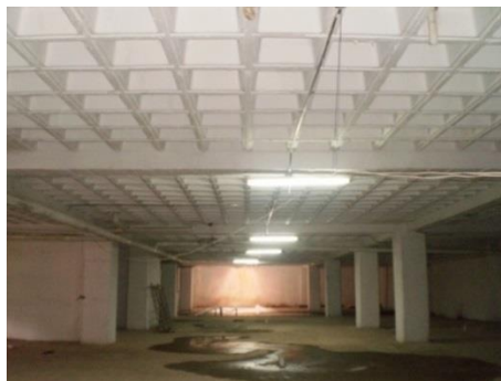
Foto 50. Losa de uno de los dos subsuelos del Edificio ubicado en la Calle Víctor Albornoz. Losa aligerada, construida con bloques plásticos que se recuperan después de la fundición.
