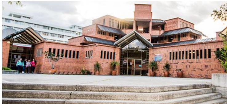
Foto 39. Facultad de Odontología de la Universidad de Cuenca, edificio de estructura de hormigón armado construido con Sistemas de Encofrados. Ubicación, aledaño al Hospital Vicente Corral Moscoso. Construcción año 2004. Arq. Honorato Carvallo. Fuente: www.odontoecuador.com.ec
