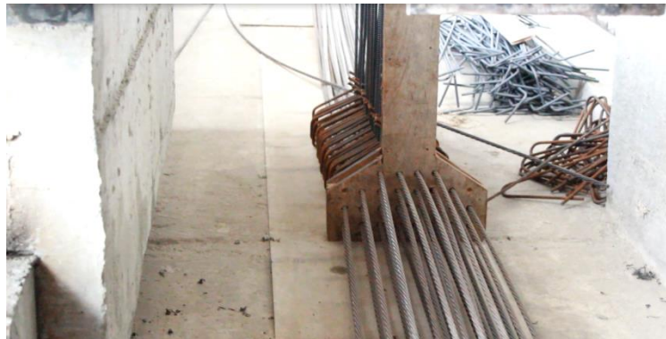
Foto 60. Colocación de cables para viga de puente, fábrica Carrasco RFV Construcciones.
