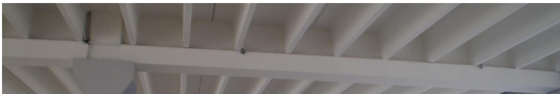
Foto 99. Viga cargadora tipo T invertida prefabricada de hormigón pretensado, “Ferretería Continental”
