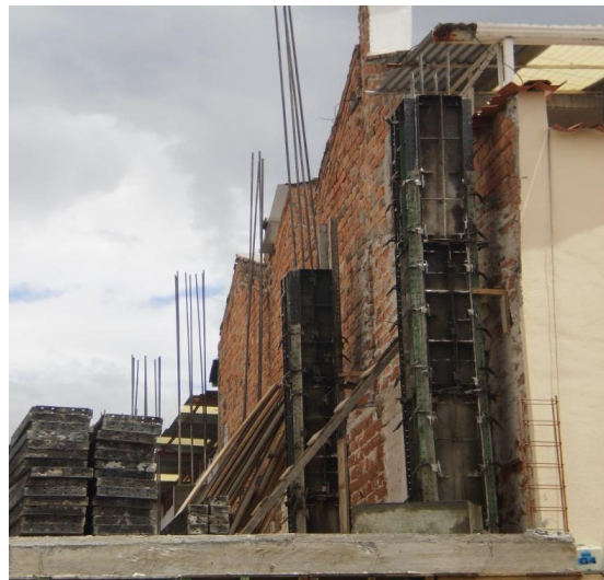
Foto 34. Columnas con encofrado metálico. Vertido de hormigón de forma manual. Edificación Calle Juan Jaramillo.
