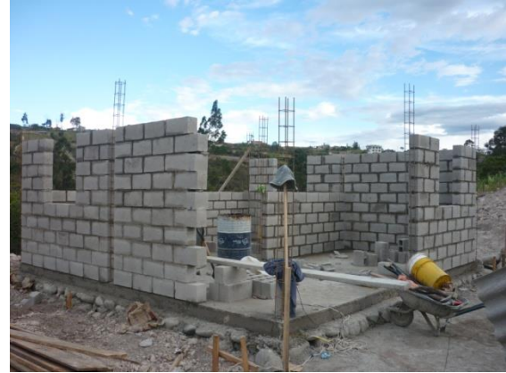
Foto 22. Vivienda unifamiliar, área de construcción 194 m 2 . Estructura de hormigón armado y mampostería de ladrillo, todo construido de forma tradicional. Arq. Adriana Criollo. Parroquia El Valle.
