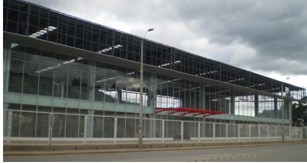
Foto 95. Edificación "Ferretería Continental", construido con elementos prefabricados en su totalidad, ubicado en Av. de las Américas, sector Control Sur.
