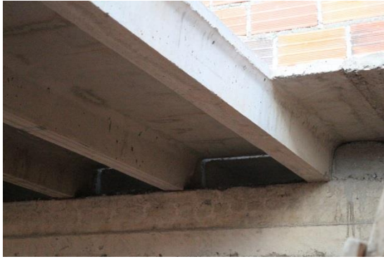
Foto 90. Losas doble T prefabricadas, se adaptan a diseños arquitectónicos y estructurales. Calle Benito Juárez
