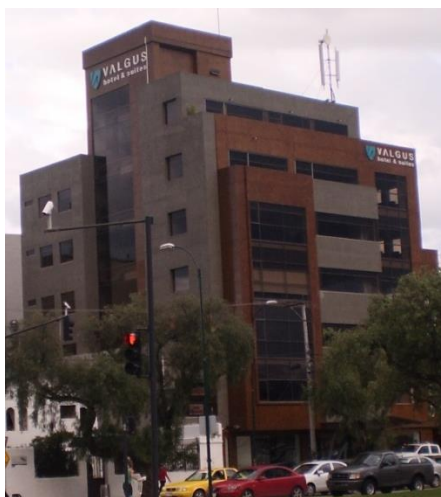
Foto 42. Edificio Valgus, ubicado en la Av. Solano. Construido con Sistemas de Encofrados, y colocación del hormigón para elementos estructurales con ayuda del camión mixer de concreto Arq. Janet Altamirano.
