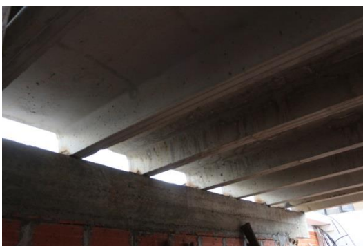
Foto 89. Losas de sección doble T prefabricadas, luz 6 m, para losa de entepiso. Arq. Carlos Contreras. Calle Benito Juárez
