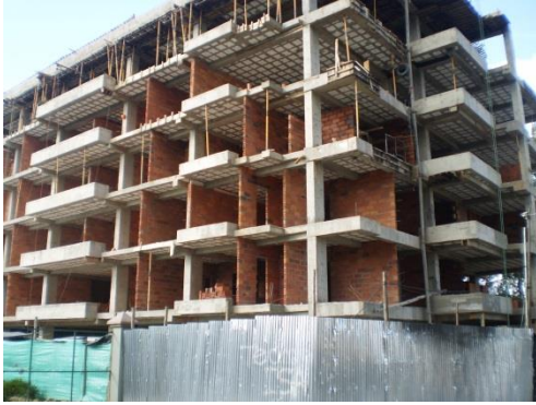
Foto 57. Edificación multifamiliar de seis plantas, estructura de hormigón armado, en vanos relleno con mampostería de ladrillo, la colocación del hormigón se realiza mediante mixer de concreto. Área de construcción 6886 m 2 . Arq. Marco Arias. Tiempo de ejecución de la obra dos años. Av. Primero de Mayo.
