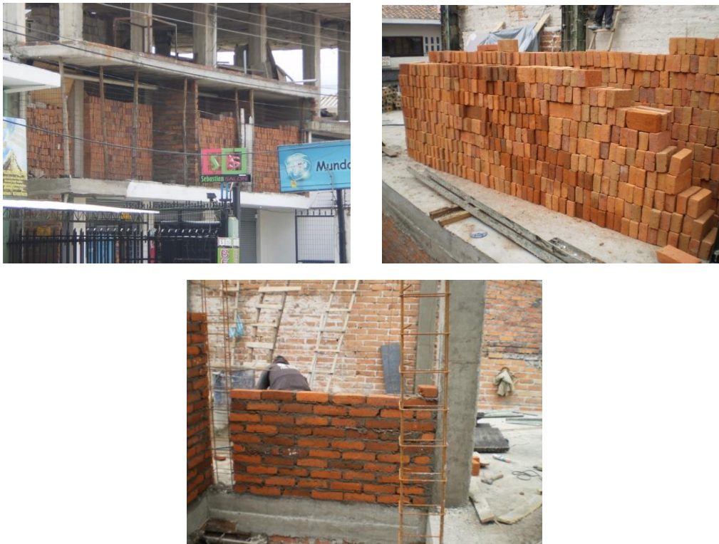
Foto 10. Almacenaje de ladrillo en obra y uso en mampostería. Edificación de tres plantas. Calle Guapondélig
