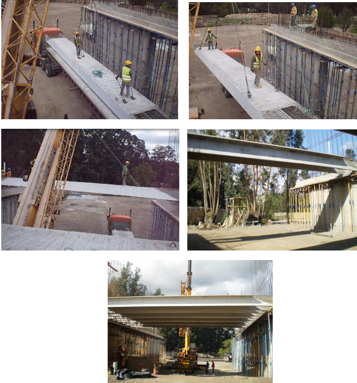
Foto 71. Proceso de montaje de losas de sección doble T para la construcción del Edificio del Aulario para el “Centro Científico, Tecnológico y de Investigación Balzay de la Universidad de Cuenca”
