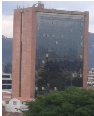
Foto 4. Edificio de la Cámara de Industrias de Cuenca, ubicado por el sector del Parque de la Madre, construido tradicionalmente en el año 1981, la estructura del edificio es de hormigón armado. Arq. Honorato Carvallo.
