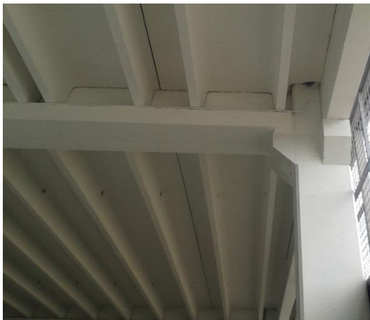
Foto 97. Columna con ménsula, viga cargadora y viga de amarre, constituyen la estructura de la losa de entrepiso de la edificación de la "Ferretería Continental"
