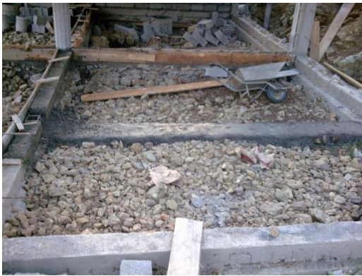
Foto 18. Vigas de cimentación, con encofrados y hormigón elaborados en obra. Resultado de la práctica de la albañilería. Vivienda de dos plantas. Construcción tradicional. Sector San Joaquín.
