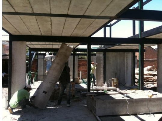
Foto 93. Paneles alivianados, de fácil manejo sin necesidad de grúas. Fuente: Ing. Fernando Zalamea
