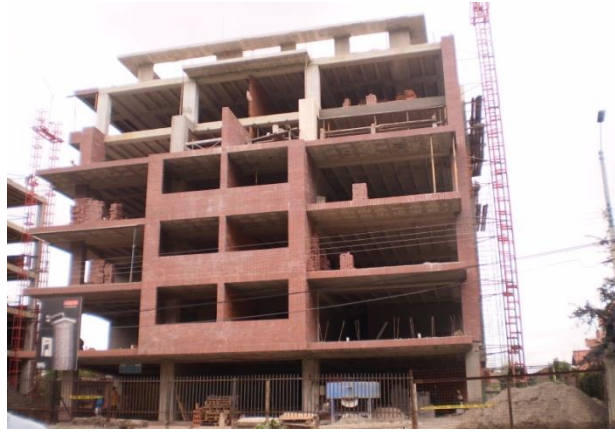
Foto 53. Edificación de seis plantas, sector Balzay. Calle Rafael Fajardo. Construcción con Sistemas de Encofrados metálicos y aplicación de hormigón mediante mixer de concreto. Calle Rafael Fajardo.
