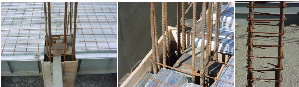
Foto 13. Armado de acero de refuerzo de elemento estructural: columna, que corresponde al diseño estructural realizado previamente por el Ingeniero Estructural. Vivienda de tres pisos. Sector San Joaquín
