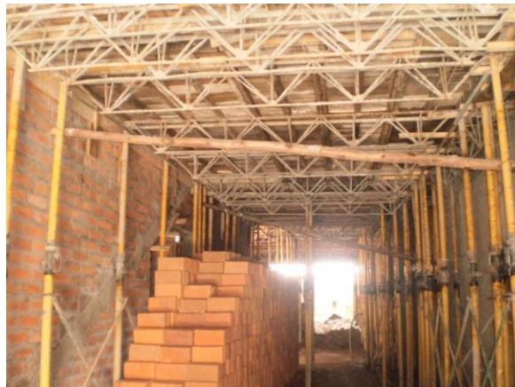
Foto 48. Puntales y Cercha metálica de una edificación.
