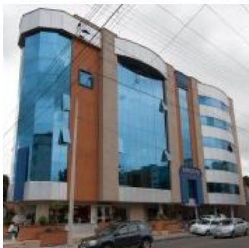
Foto 40. Edificio Work Center, ubicado en la Av. Paucarbamba. Construido con Sistemas de Encofrados, y colocación del hormigón para elementos estructurales con ayuda del camión mixer de concreto. Arq. Janet Altamirano.
