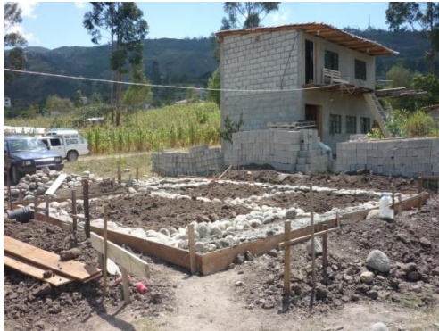
Foto 25. Vivienda de dos plantas, con encofrados de madera desde los cimientos, elaborados de forma artesanal en obra. Construcción de vivienda se prevé con muros resistentes de ladrillo. Área de construcción 282 m 2 . Arq. Rosa G. Parroquia Chiquintad.
