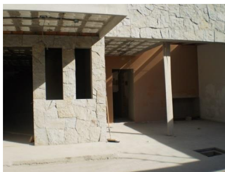
Foto 28. Vivienda de dos plantas, con estructura de hormigón armado, los encofrados utilizados fueron de madera y la construcción de mampostería es de ladrillo, área de construcción de 140 m 2 . Parroquia Yanuncay
