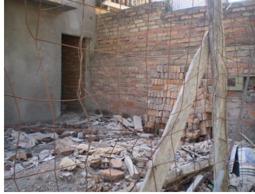
Foto 29. Vivienda de dos plantas, para construir la estructura de hormigón se empleó encofrados de madera elaborados artesanalmente en obra, y para la construcción de paredes y muros se utiliza el ladrillo. Parroquia Sucre
