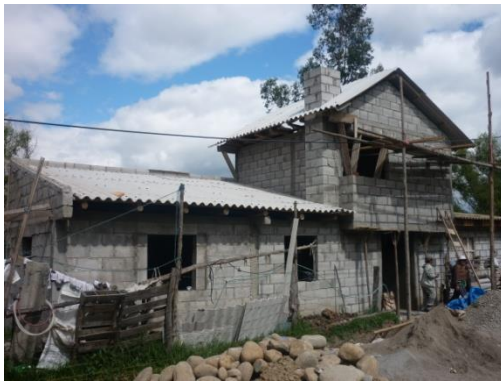
Foto 20. Vivienda de plantas. Parroquia Ricaurte. Área de construcción 495.6 m 2 . Estructura de hormigón armado y mampostería de ladrillo, todo construido de forma tradicional. Arq. María Clavijo.
