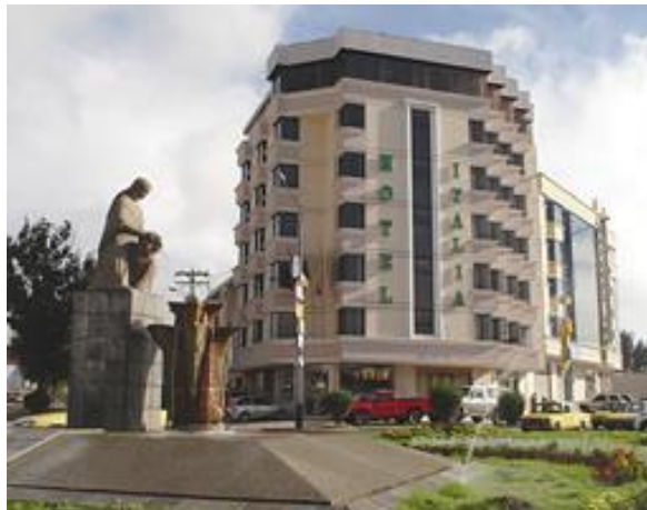
Foto 2. Hotel Italia, ocho plantas construidas tradicionalmente, con hormigón elaborado y colocado en obra y la incorporación de encofrados metálicos, en el año 1977 con un tiempo de ejecución de doce meses. Área del terreno 350 m2. Sector Chola Cuencana. Arq. Claudio Ullauri.
