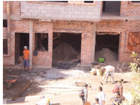
Foto 27. Vivienda de dos plantas, construcción con estructura de hormigón armado elaborado en obra, los encofrados utilizados son de madera y mampostería de ladrillo, tiempo de ejecución de la obra diez meses. Sector Av. 10 de agosto.
