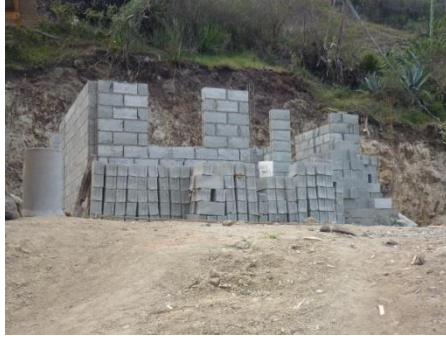
Foto 19. Vivienda de una planta, construcción tradicional de estructura de hormigón armado elaborado en obra y mampostería de bloque. Parroquia Sinincay. Arq. Henry Villazhañay
