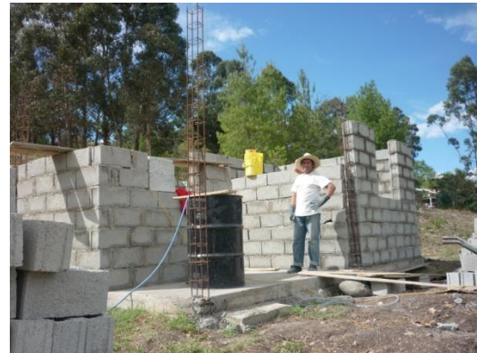
Foto 23. Vivienda de dos plantas, área de construcción 282 m 2 . Arq. Rosa G. Parroquia Monay. Construcción tradicional de estructura de hormigón armado elaborado en obra y mampostería de bloque.
