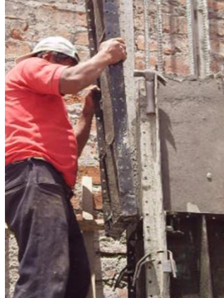
Foto 46. Proceso de desencofrado de columnas.
