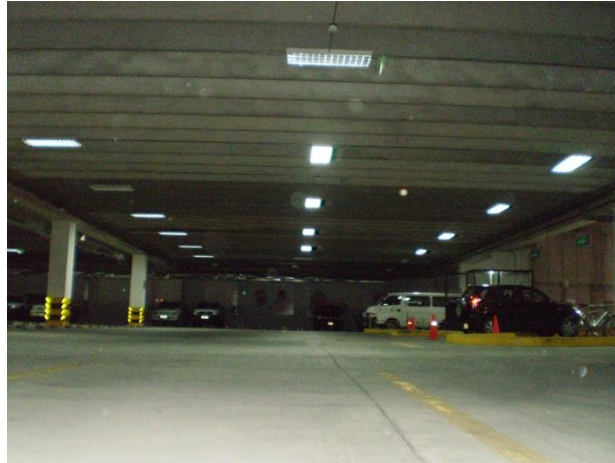
Foto 101. Parqueadero del "Parque de la Madre", construido con elementos prefabricados de hormigón pretensado.
