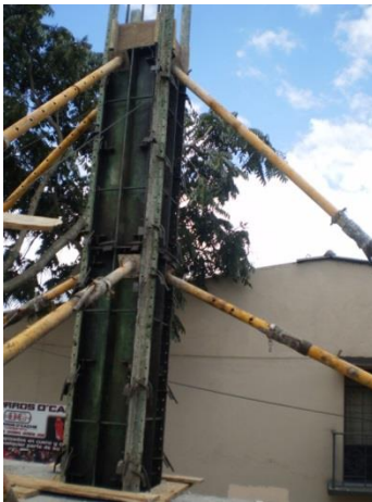
Foto 36. Encofrado Metálico en columnas. Edificación calle Manuel Vega.
