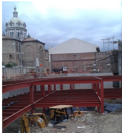
Foto 12. Edificación con estructura de acero. Calle Huayna Cápac y Simón Bolívar.
