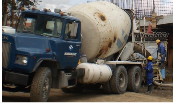
Foto 38. Camión “mixer de concreto” utilizado en las construcciones para bombear el hormigón y alcanzar sin problema alturas elevadas para fundición de elementos estructurales de edificios
