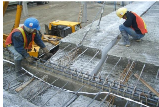
Foto 70. Proceso de montaje, de losas de sección T, utilizadas en la construcción del Parqueadero subterráneo en el proyecto: “Rehabilitación del Parque de la Madre”, que se realizó en el año 2012.
