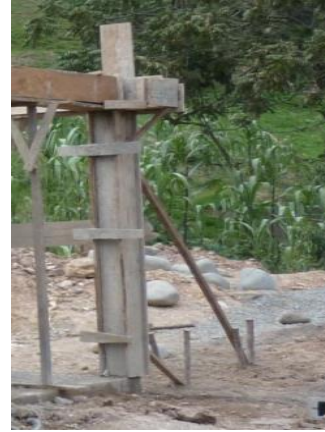
Foto 17. Encofrado de columnas, elaboradas artesanalmente y puntales de madera. Edificación de una planta, área de construcción 120 m2. Arq. Bolívar Abarca. Parroquia Ricaurte.
