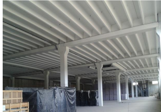
Foto 96. Subsuelo "Ferretería Continental", construido con elementos prefabricados de hormigón pretensado para losa de sección doble T.
