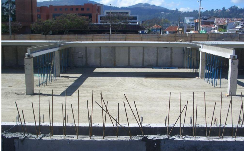
Foto 103. Viga cargadora tipo T invertida prefabricada de hormigón pretensado, Parqueadero del "Parque de la Madre".
