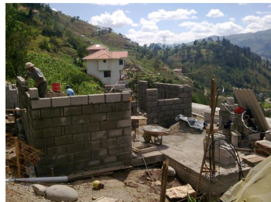
Foto 24. Vivienda unifamiliar, área de construcción 124 m 2 . Claro ejemplo de albañilería pura, en la construcción de vivienda con muros estructurales simples. Arq. Rafael Méndez. Parroquia El Valle.
