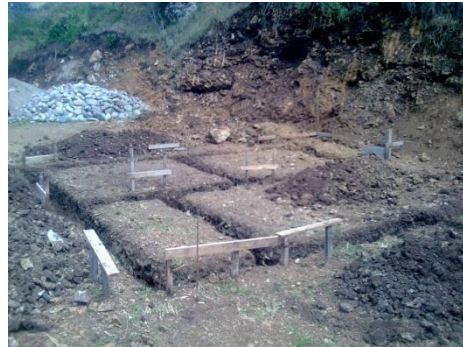
Foto 26. Vivienda de dos plantas, cuya construcción será realizada de forma tradicional, con hormigón elaborado en obra, y encofrados de madera. Área de construcción 306 m 2 . Arq. Víctor León. Sector Castilla Cruz.
