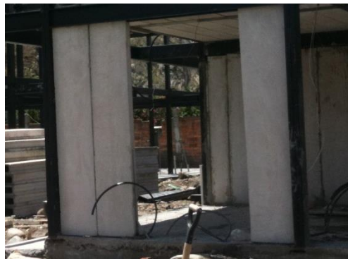
Foto 91. Paneles alivianados prefabricados para elementos verticales como paredes de Unidad Educativa. Fuente: Ing. Fernando Zalamea
