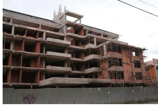
Foto 57. Edificación multifamiliar de seis plantas, estructura de hormigón armado, en vanos relleno con mampostería de ladrillo, la colocación del hormigón se realiza mediante mixer de concreto. Área de construcción 6886 m 2 . Arq. Marco Arias. Tiempo de ejecución de la obra dos años. Av. Primero de Mayo.
