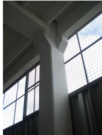
Foto 97. Columna con ménsula, viga cargadora y viga de amarre, constituyen la estructura de la losa de entrepiso de la edificación de la "Ferretería Continental"
