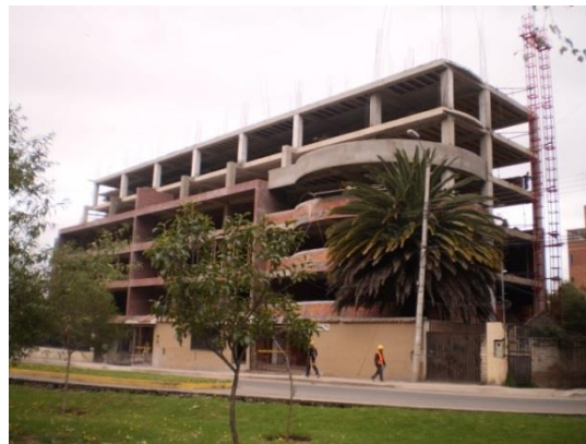
Foto 52. Edificación de seis plantas, construida con Sistemas de Encofrado y aplicación de hormigón con ayuda del mixer de concreto. Calle Rafael Fajardo. Sector Balzay.
