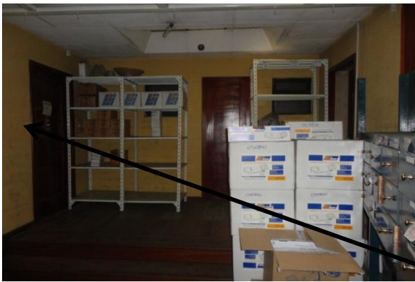
Foto 6: Colocación de extintores en bodegas
