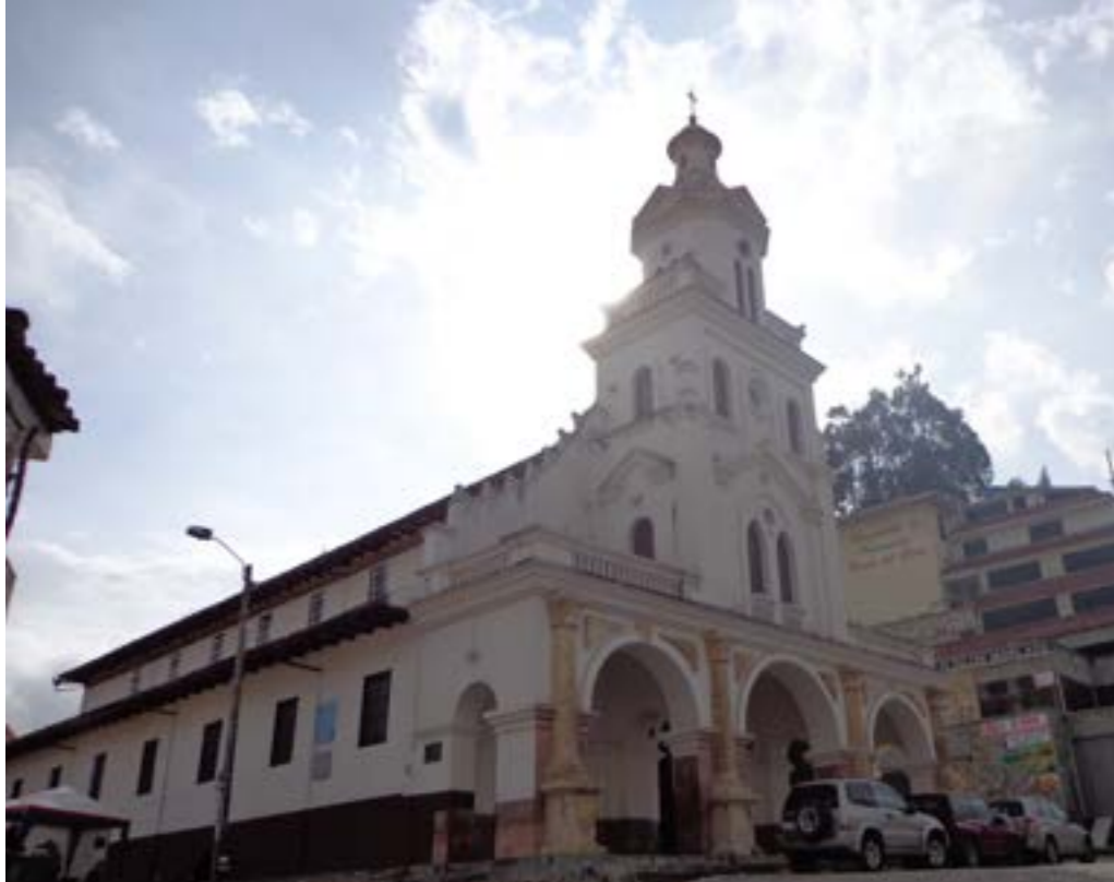
Foto N°8 Iglesia de Turi Fuente: Locación Turi Archivo: Archivo de Tesis
