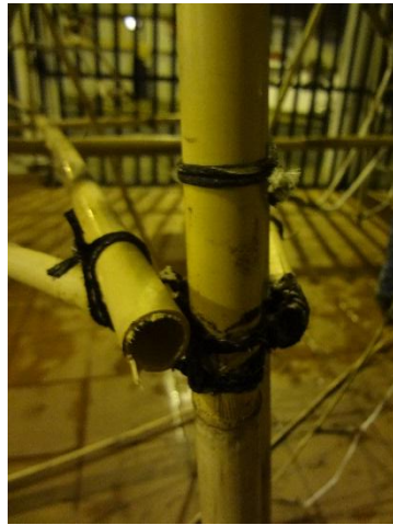
Ilustración 71 Sujeción de los carrizos para formar las estructuras Foto del autor
