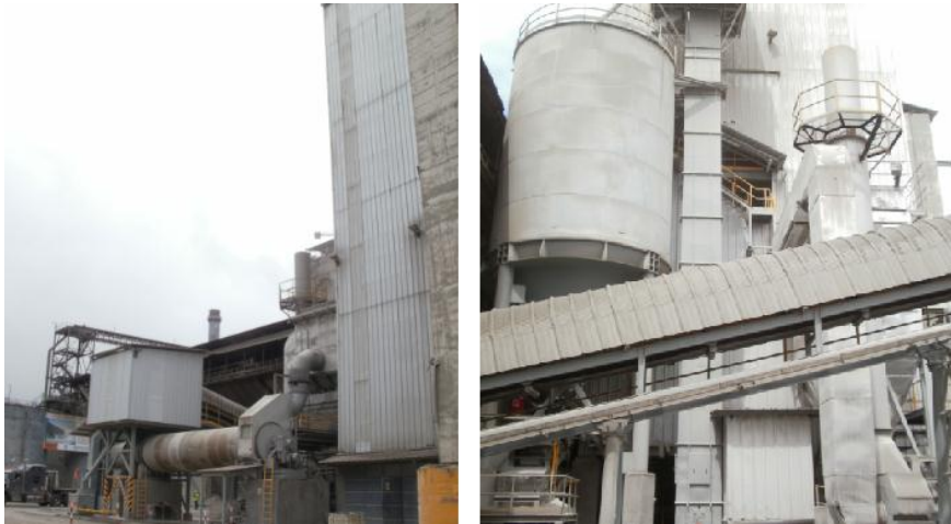
FIGURA 9. Imagen del área de secado de puzolana. Fuente: Planta Industrial Guapán.
