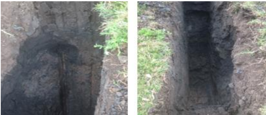
Foto 15. Excavación para el PCA 15. Ubicada en la comunidad La Posta.
