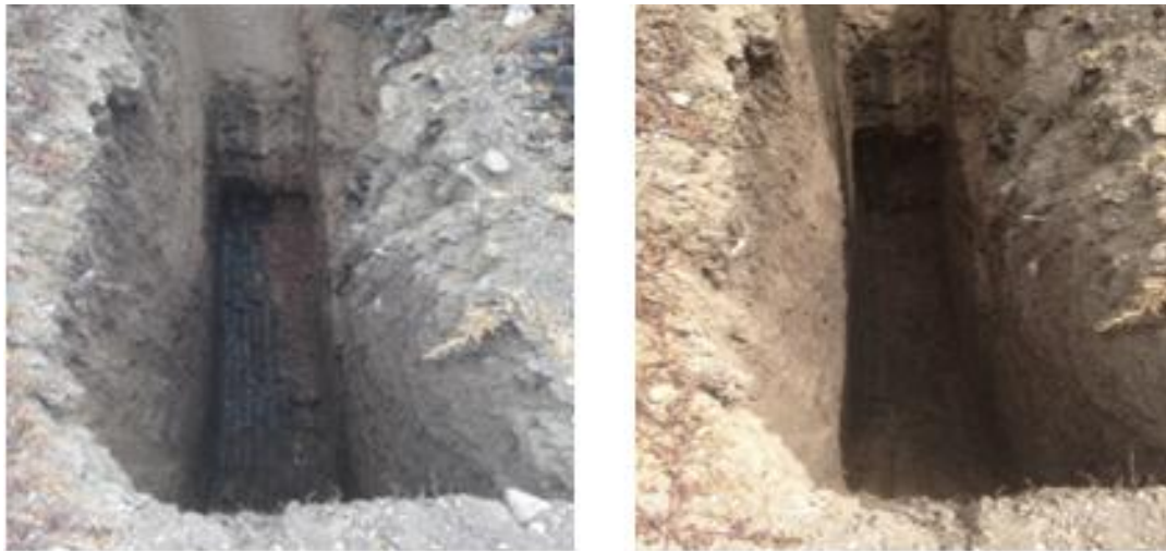
Foto 14. Excavación para el PCA 14. Ubicada en el sector de Isavieja
