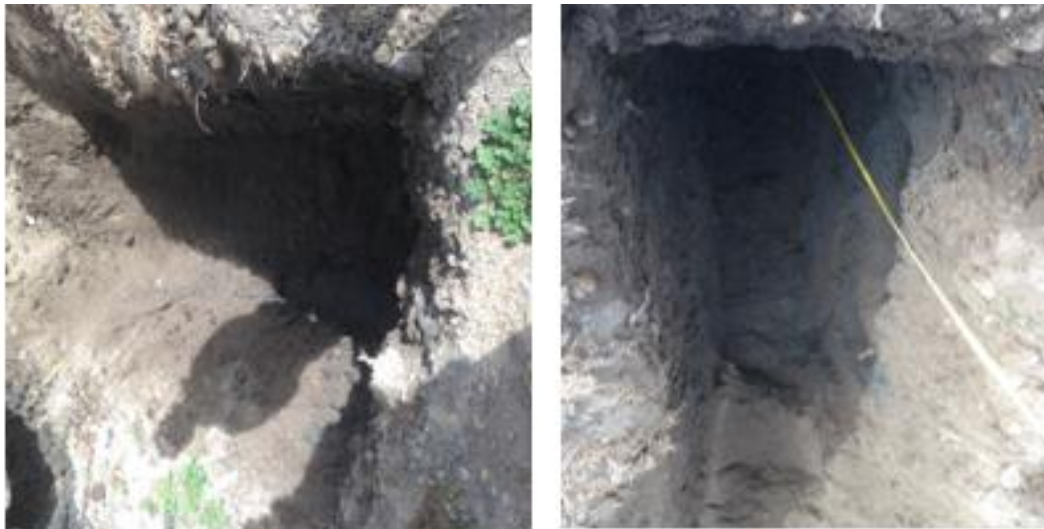
Foto 10. Excavación para el PCA 10. Ubicada en el sector de Chaglaban.
