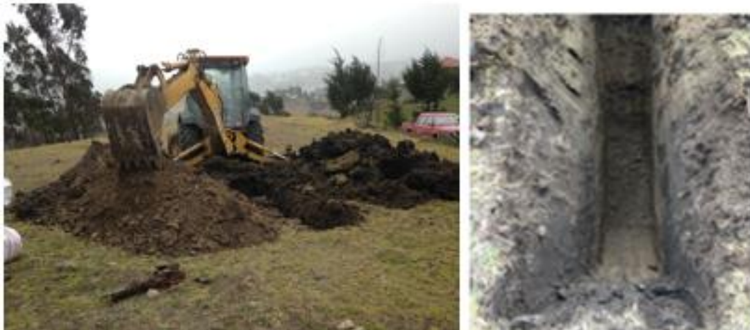
Foto 12. Excavación para el PCA 12. Ubicada en el sector de Cunducucho.
