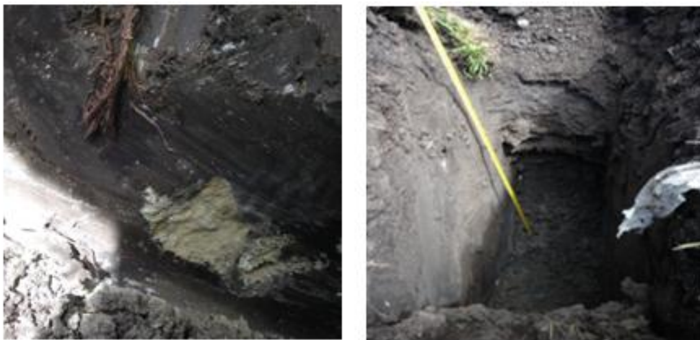
Foto 6. Excavación para el PCA 06. Ubicada en el sector de Guanto.
