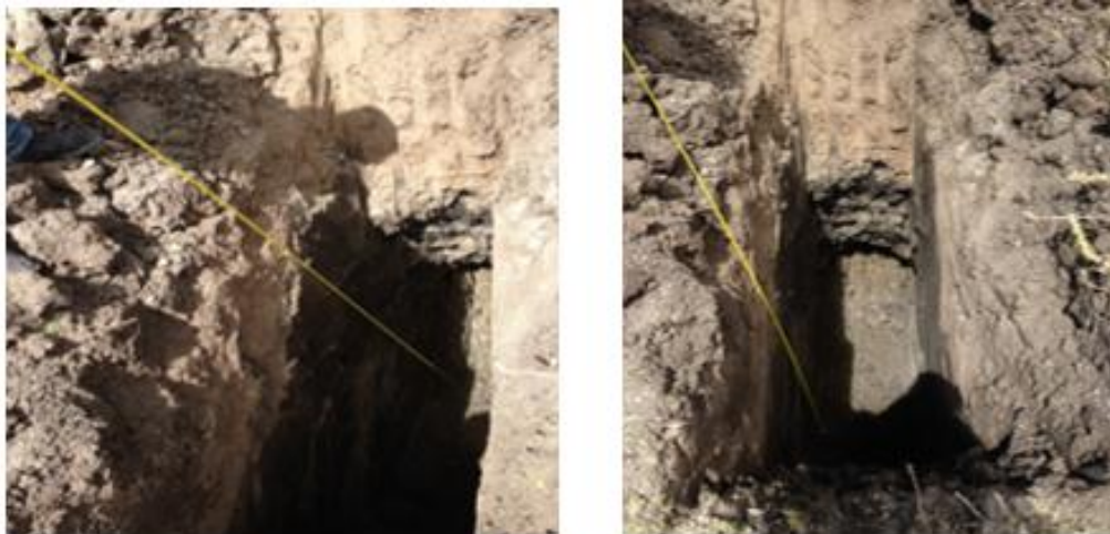
Foto 7. Excavación para el PCA 07. Ubicada en la urbanización Inti- Raymi.
