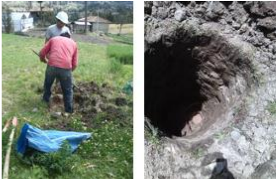
Foto 20. Excavación para el PCA 20. Ubicada en vía a La Posta
