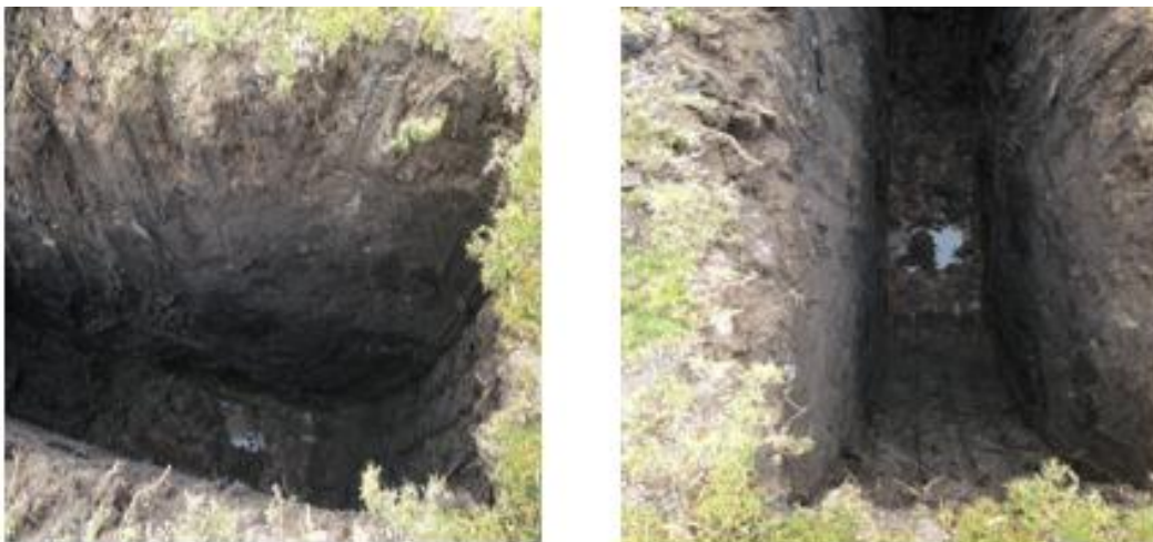
Foto 13. Excavación para el PCA 13. Ubicada en el sector de la ciudadela de Choferes.
