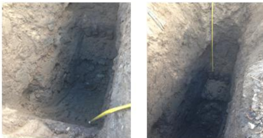
Foto 11. Excavación para el PCA 11. Ubicada en el sector de Chaglaban.
