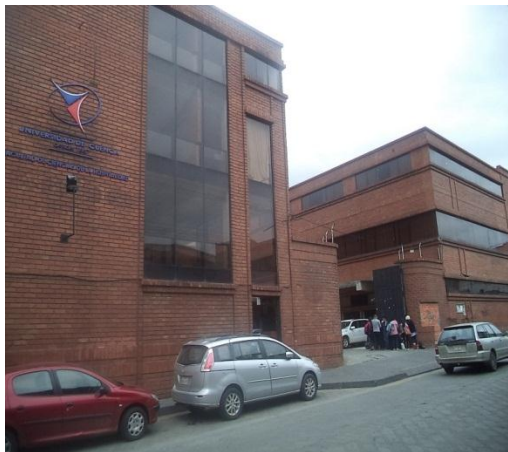
Fotografía 15. Edificio central Facultad de Ciencias de la Hospitalidad. Fuente: Los autores.
