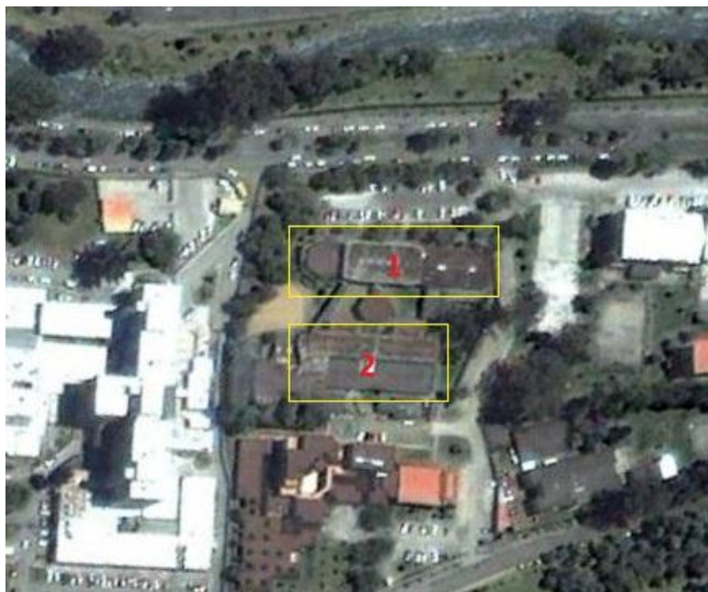
Fotografía 7. Vista satelital Escuela de Medicina Fuente: Google Earth.
