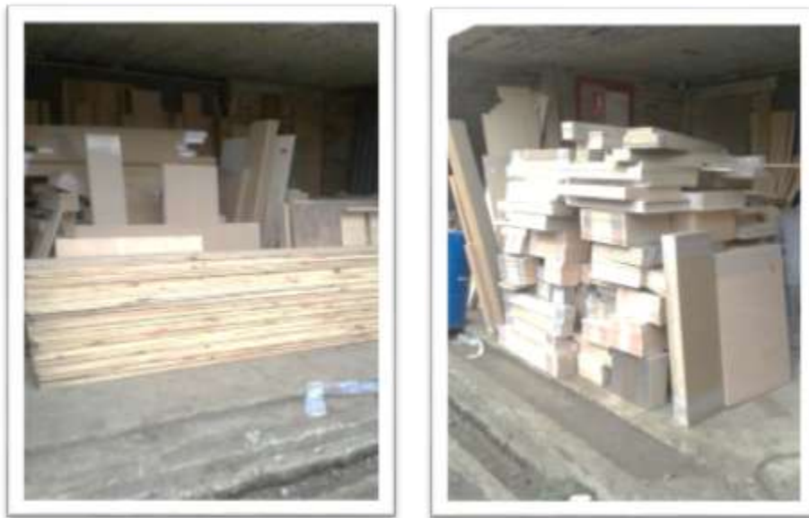
IMAGEN 17: Almacenamiento tableros (espacios exteriores)
