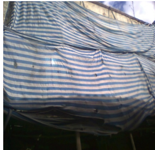
Edificación abandona ubicada en la calle Tarqui entre Larga y Pte. Córdova
