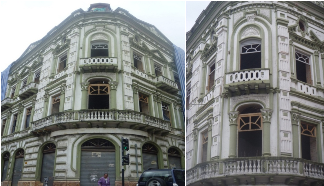
Edificación en proceso de reconstrucción después del flagelo en el 2010(Sucre y Padre Aguirre)
