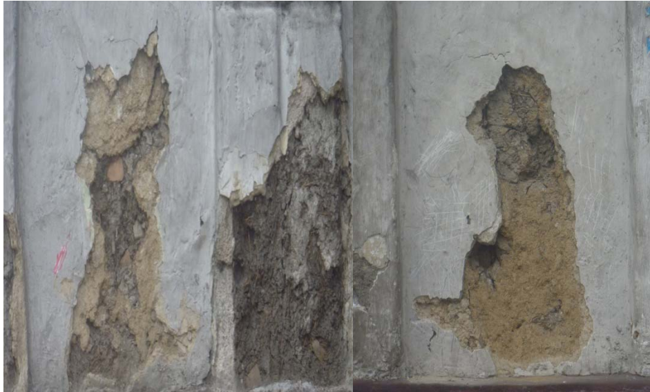
MATERIAL MODERNO (CEMENTO) QUE NO COHESIONA CON EL ADOBE
