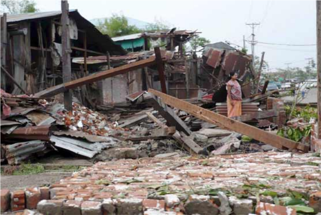
Ilustración Uno de los derrumbes ocurridos en la Costa ecuatoriana.
