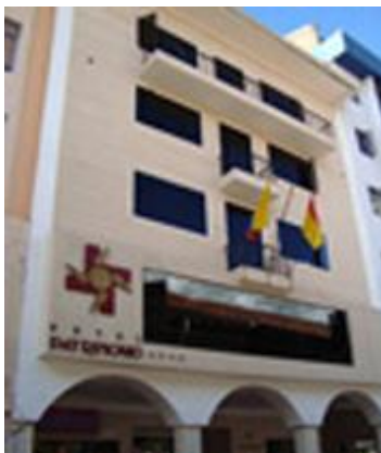
Imagen: 052 Título: Fachada principal del hotel Autor: Hotel Patrimonio Fuente: http://www.patrimoniohotel.com/ Fecha: 21 julio 2011.
