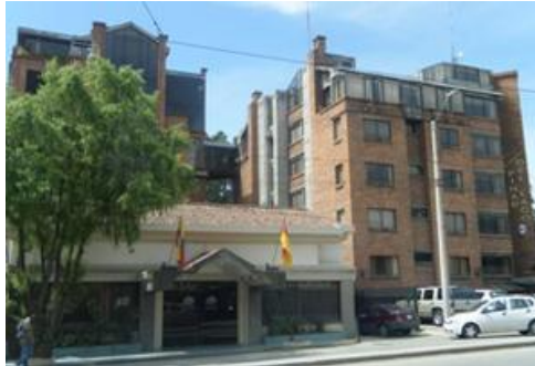
Imagen: 060 Título: Fachada principal del hotel Autor: Hotel Pinar del Lago Fuente: Fecha: 2 agosto 2011.
