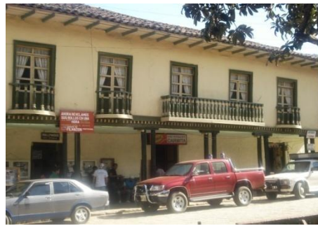
Fachada frontal casa Familia Mosquera
