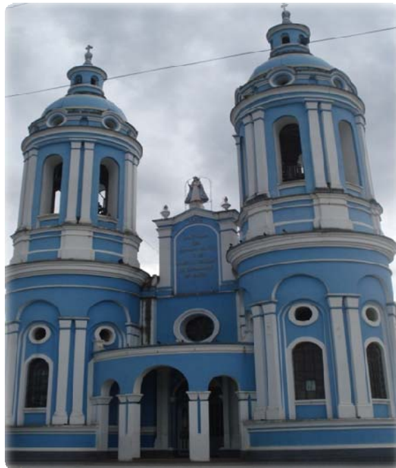
Foto Nº 5 y 6 Fuente: Propia Autor: Franklin Márquez Descripción: Iglesia parte frontal y lateral Fecha: 22/05/2010
