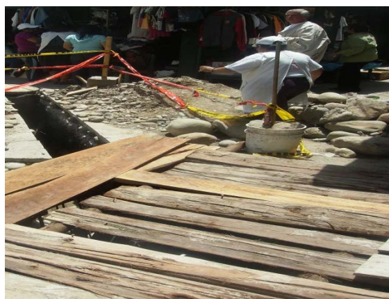
Figura #11 Puerta Lateral del Mercado “12 de Abril”
