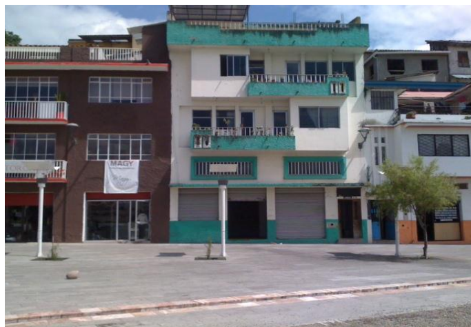
Figura: 2.5 Fotografía de la fachada del local
